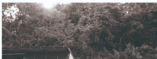
■空き家・廃屋だけでなく、今にも崩落しそうな急傾斜地の対策も重要です。所有者に適正管理を促せるような仕組みをつくるため、今後も働きかけて参ります。
