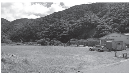
名瀬朝戸地区の学校給食センター建設予定地。米飯給食センターの隣です。現在、配送車用の車庫を建設中。安全・衛生面を重視し、食物アレルギーにも対応した給食を提供できるよう準備中です。より良い給食運営ができるよう、求めています。
